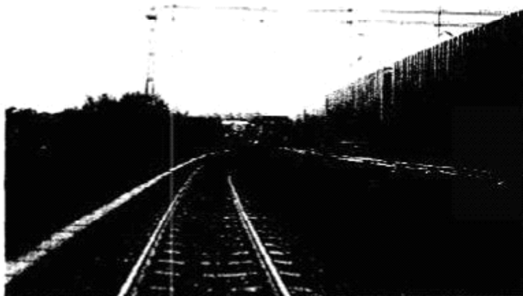
Körväg öster ut på spår i Kville bangård för de återgående loken från tåg
